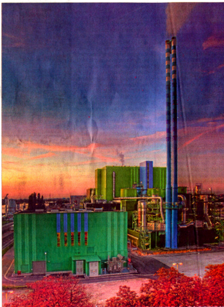
Das weithin sichtbare Müllheizkraftwerk auf der Ingelheimer Aue ist technisch eine hochkomplexe Angelegenheit. Entsprechend aufwendig sind Revisionen.
