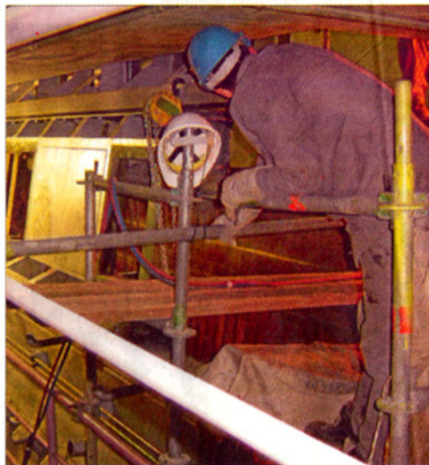
Durch die Trichterklappe wird der Müll von oben in die Anlage eingefüllt.
